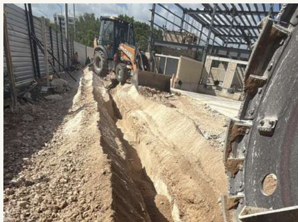
02 • Terracerías y zanjado de alta capacidad
